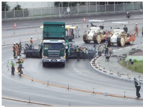
④ 9月下旬、「フェーゲル」という特殊なドイツ製舗装機械を使用し、中間層となるアスファルトを敷きならしました。
