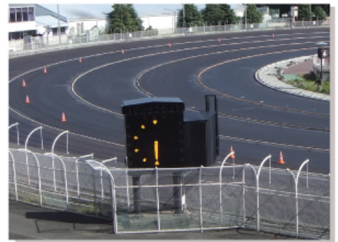
③ 9月上旬、ロードローラーで整地した最下層の表面に漆黒の接着剤を塗布し、舗装の強度を高めました。
