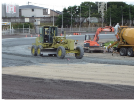
② わずか数日で走路下の白い土壌が顔を出しました。整地後、水はけを良くする最下層（砂利の層）を形成しました。
