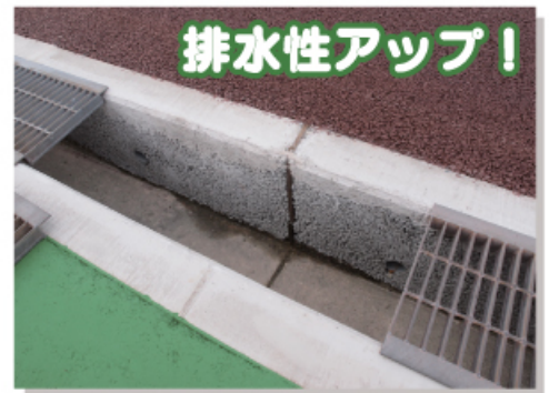
⑨ 競走路に浸透した雨水が、側溝へとスムーズに流れ出るしくみになっており、これまでにない速乾性を実現しました。
