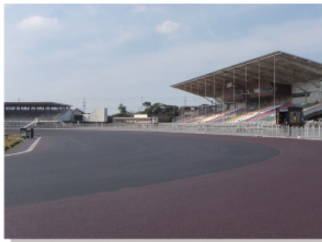
⑤ 10月中旬、最上層である競走路専用アスファルトを舗装し、バンク傾斜を確認しました。
